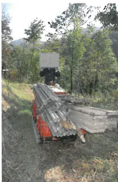
運搬車による機材搬入
