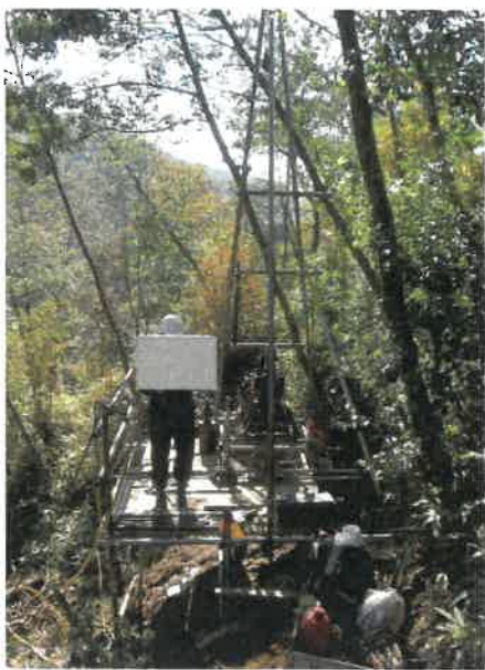
ボーリング作業
